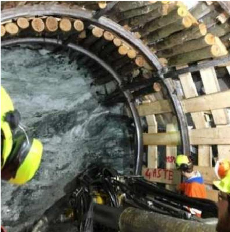
*Fig. 12. Dettaglio dello scavo di una galleria di accesso al giacimento in una zona di contatto per la coltivazione di una nuova massa mineralizzata sostenuta con centine metalliche, guarnissaggio in legno e infilaggi metallici con autoperforanti.*
