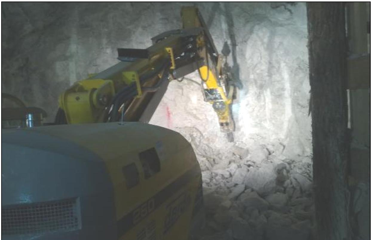
*Fig. 6 Vista del martello demolitore in azione in una trancia (Brook)*
