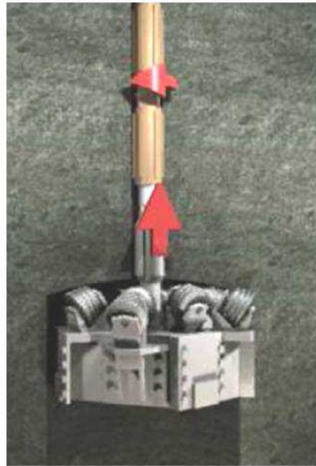
Particolare fase di alesaggio – realizzazione Fornello
